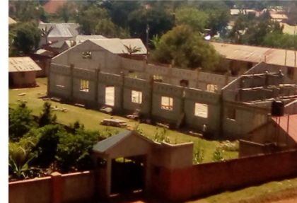
Abschluss der dritten Bauphase
